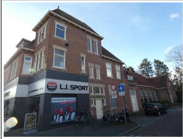
Foto 1 zuid- en oostgevel
