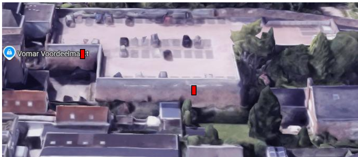
Noordoostgevel van parkeerruimte van Vomar voordeelmarkt
