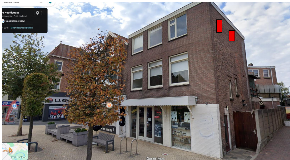
Hoofdstraat 195a noordoostgevel (ook noordwestgevel van dit gebouw zou een goede optie zijn)
