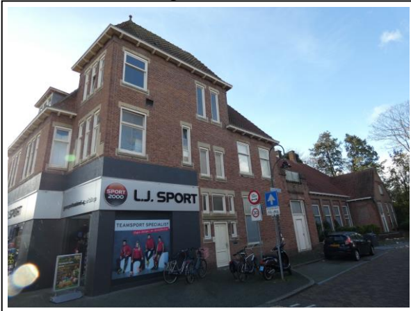
Foto 1 zuid- en oostgevel
