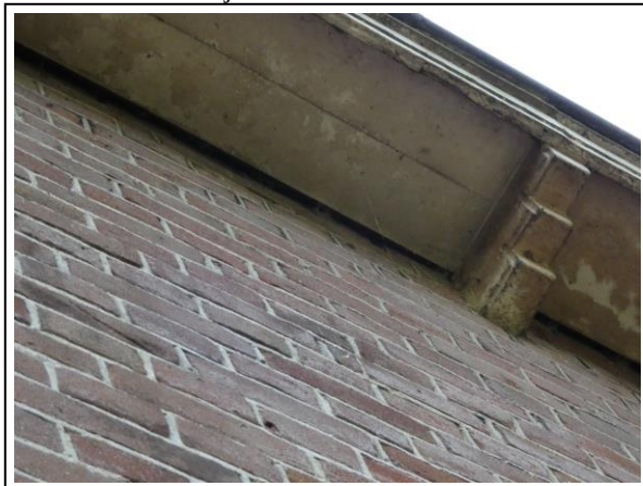
Foto 6 ruimte bij de dakrand
