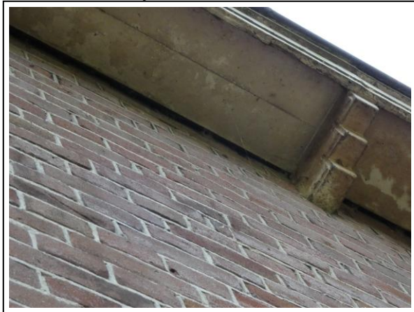
Foto 6 ruimte bij de dakrand
