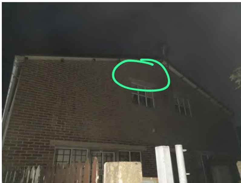
Afbeelding 1, locatie van vleermuis verblijfplaats bij de noordgevel van Hoofdstraat 189-189a
