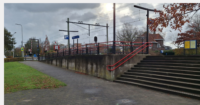
Opgangen van het perron met hellingbaan richting de Herenstraat
