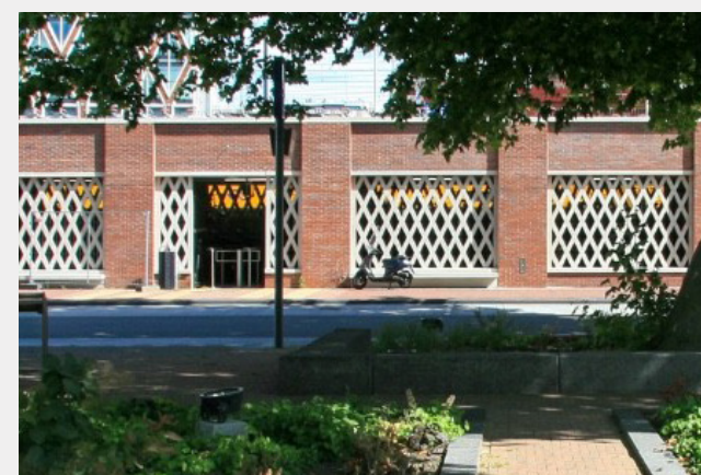
Fietsenstalling onderdeel van de perronmuur. Openingen in de bakstenen gevel zorgen voor zicht en daglicht (Station Gouda, De Nijl Architecten).
