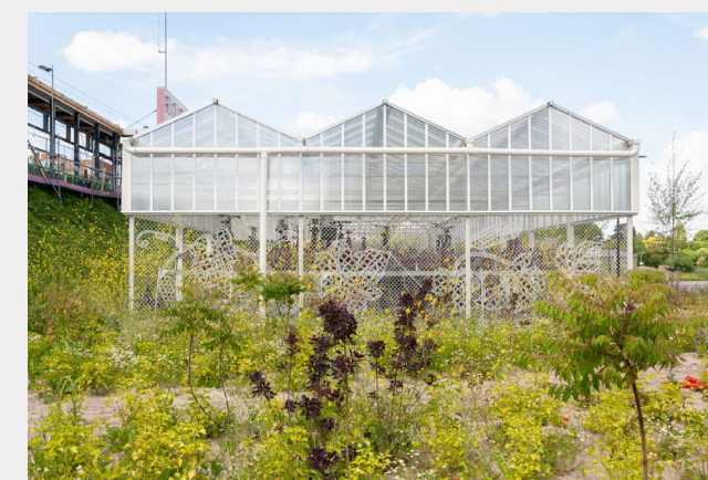
Transparante fietsenstalling. Glas en hekwerk zorgen voor zicht en daglicht. (Metrostation Rodenrijs, DaF-architecten)
