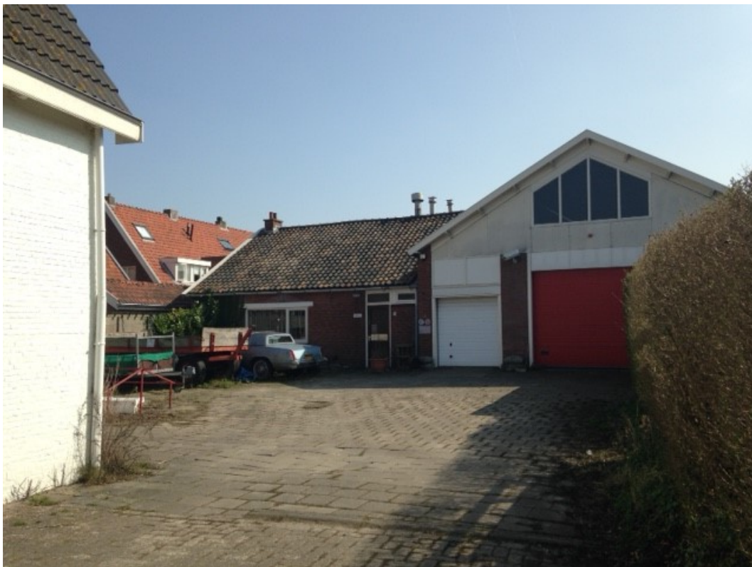
Bedrijfsruimte Parklaan 134 met eigen buitenterrein
