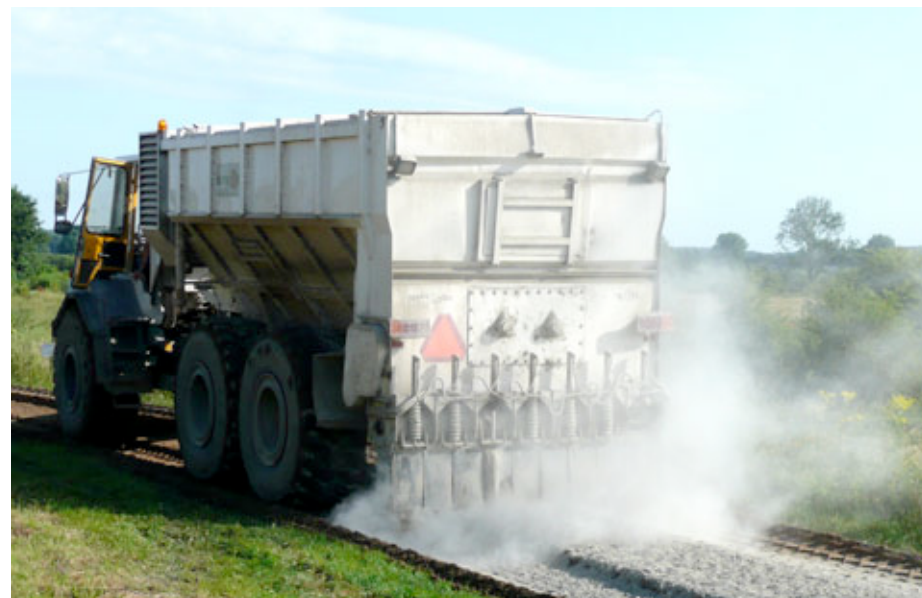
Foto 5 : Het uitstrooien van de bindmiddelen met speciale strooi voertuigen.
