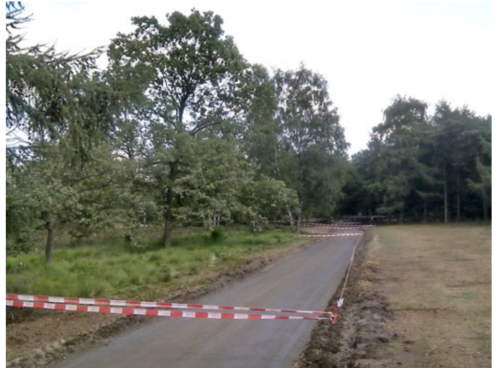
Afb. 8: : Een deel van het tracé NA de GeoCrete® ST01 behandeling
