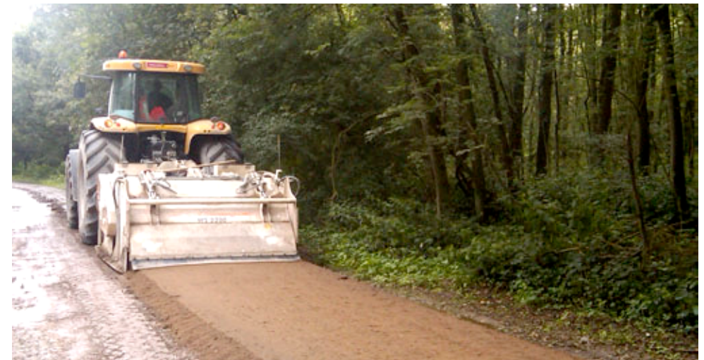
Afb. 6: Het infrezen van de bindmiddelen.
