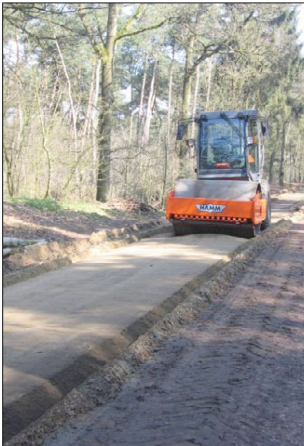
Afb. 10 :Verdichten met 7 ton's dynamische HAMM trilrol.
