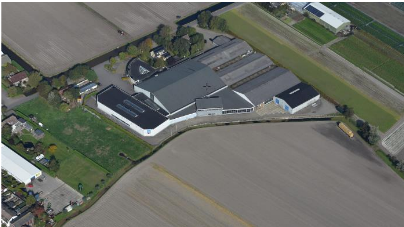
Afbeelding 3: Luchtfoto bebouwing bestaande planologische situatie (toegestaan volgens bestemmingsplan).
